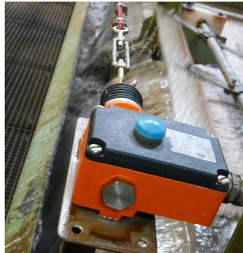
*I sistemi di flottazione sono messi in sicurezza utilizzando gli interruttori di emergenza a fune.*
